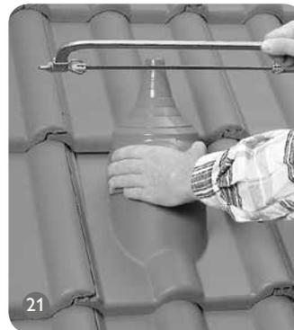
Der DuroVent Antennenaufsatz ist geeignet für die Dachdurchführung von Antennenmasten. Minimaler RohrØ: 22 mm
